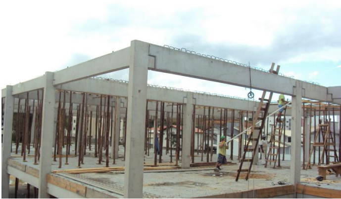
Montagem das lajes de cobertura para concretagem.
