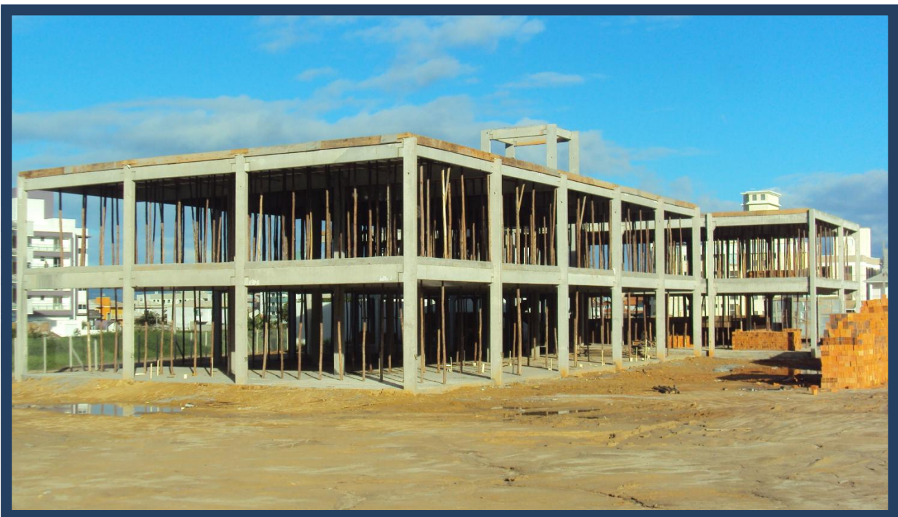
Concretagem das lajes de cobertura.
